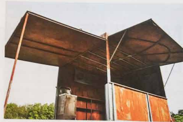
Der Fußboden besteht aus Aluminium, der Rest aus Schwarzstahl. Und weil die Heckklappe so schwer zu öffnen ist...
